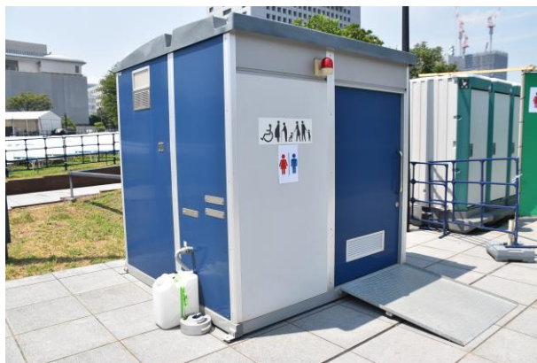
9. 多目的仮設トイレ
