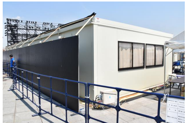
15. 楽屋 (観客席側黒パネルは、空調機器の目隠し)
